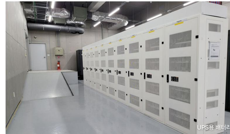
더존비즈온은 데이터와 서비스의 안정적인 연속성을 확보하기 위해 전력 공급 사고에 대비한 다양한 설비를 구축하고 있습니다. 특히 정전 발생 시, UPS 배터리 시스템을 통해 서버 및 네트워크 장비에 무정전 전원을 공급하여 서비스 중단 없이 운영을 유지하고 있습니다.
